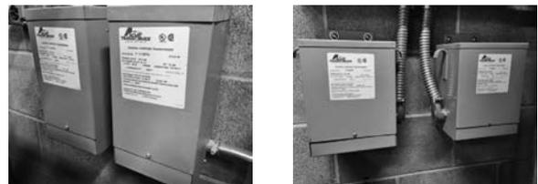
1.5KVA×2台トランス(30A) 3KVA×2台トランス(60A)
